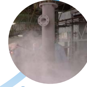
4 浸漬中の鋼管
