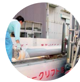
5 浸漬後の鋼管
